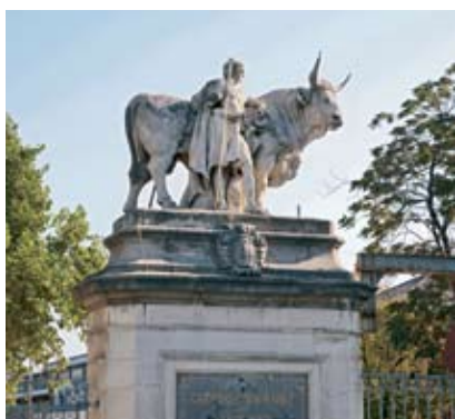
Das denkmalgeschützte Stiertor blieb
