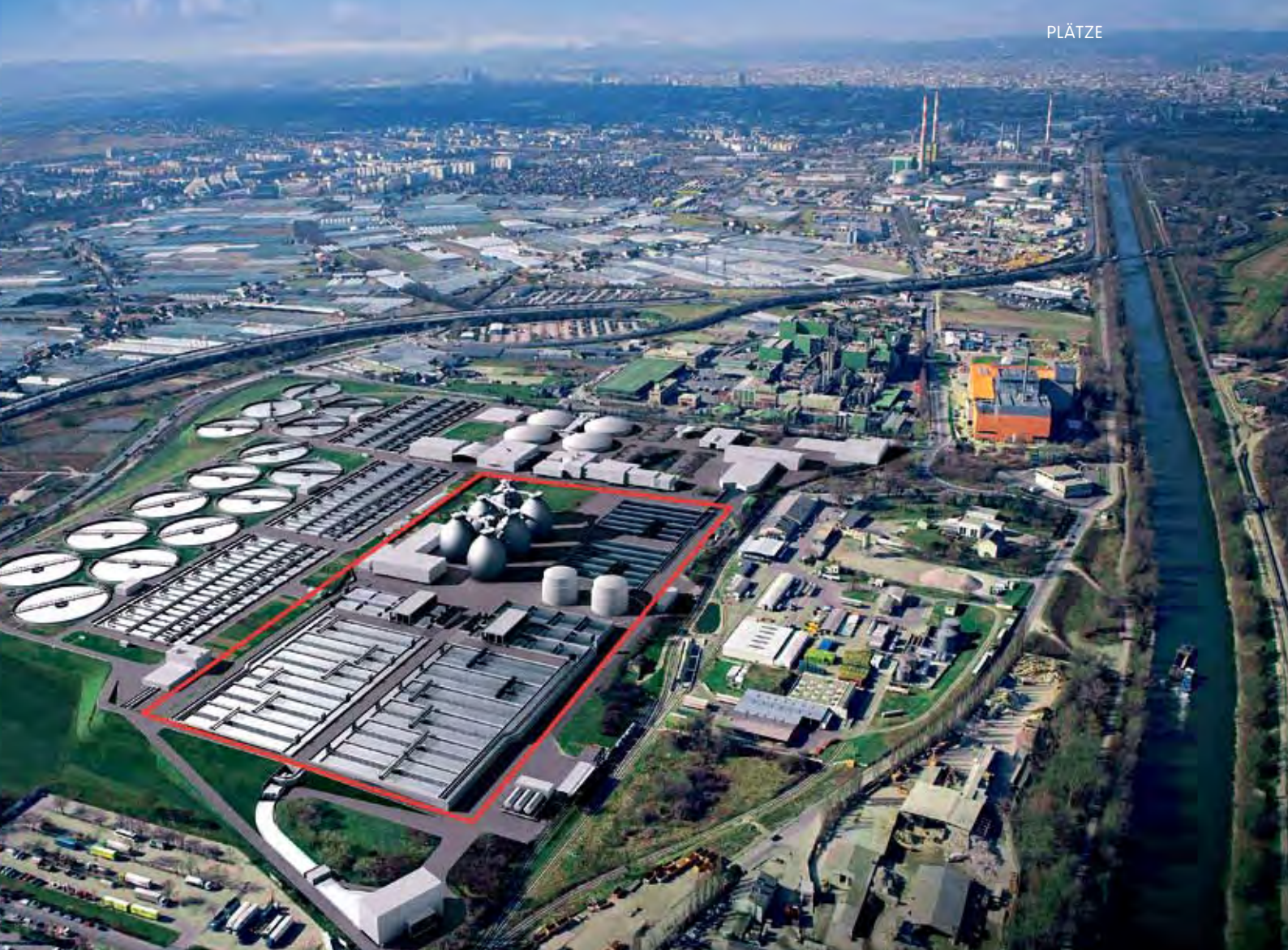
Schlammbehandlung – macht die Hauptkläranlage ab 2020 energieautark
